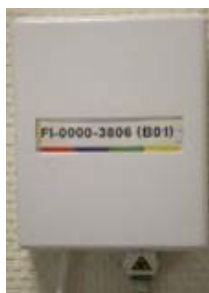
Figure 8 : FTTE passif NRO - exemple de PTO
