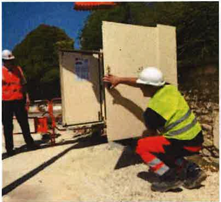
L'installation d'armoires pour la fibre optique est en cours (Ici au faubourg d'Aunis). PHOTO PH. B.
