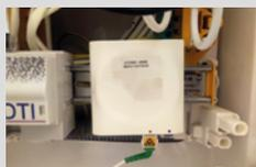
Le **PTO (Point de terminaison optique)** est situé dans le logement des abonnés, suite à la réalisation du raccordement par un opérateur. Il convertit le signal lumineux de la fibre en un signal électrique pour connecter la box.
