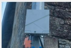
Le **PBO (Point de branchement optique)** est la partie terminale du réseau public. Il est situé au plus près des habitations, sur des poteaux, dans des chambres souterraines, en façade des immeubles ou encore dans les colonnes montantes. Un PBO permet de raccorder 6 à 12 logements.
